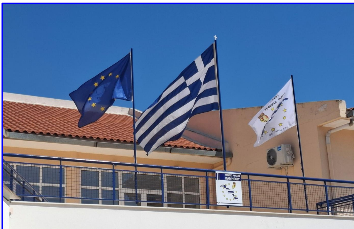
Εικόνα 18. Ιστοί σημαίων – επισκευή κιγκλιδωμάτων 1 ου ορόφου
