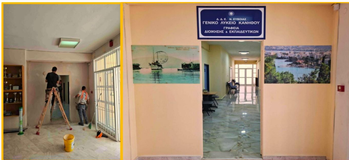
Εικόνα 22. Αποκατάσταση εσωτερικής εισόδου γραφείων
